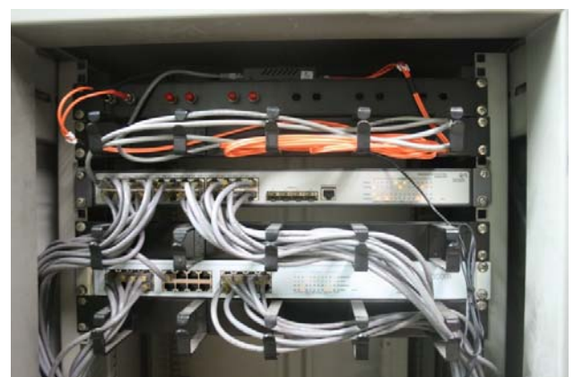
ภาพ : จัดเก็บสายไฟเบอร์ออฟติกแพทช์บอร์ดเข้าอุปกรณ์แผงจัดสายสัญญาณให้เรียบร้อย
