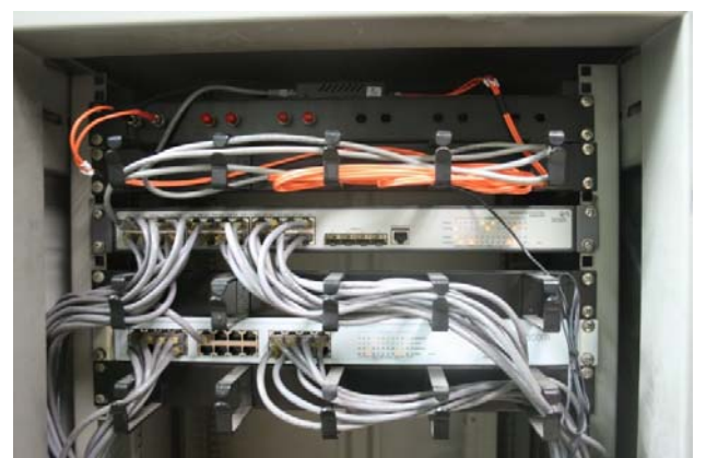
ภาพ : จัดเก็บสายไฟเบอร์ออฟติกแพทช์บอร์ด
