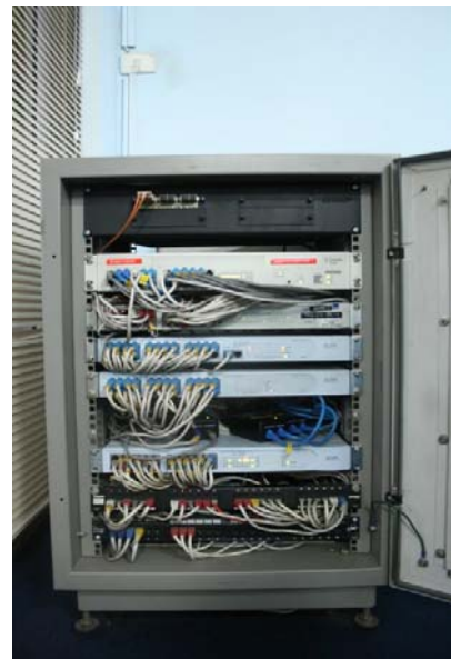
ภาพ : อุปกรณ์สวิตช์รองรับสายสัญญาณจากอุปกรณ์ไอซีที
