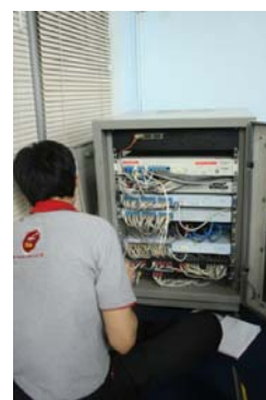
ภาพ : ตรวจสอบการเชื่อมต่อภายในตู้แร็ค
