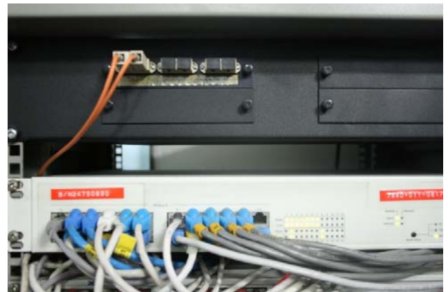
ภาพ : ตรวจสอบหัวต่อสายไฟเบอร์ออฟติก
