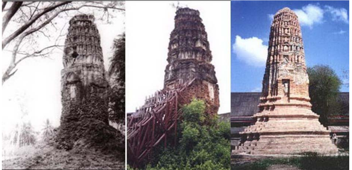
พระปรางค์วัดปรางค์หลวง (ก่อนบูรณะและหลังบูรณะ)
