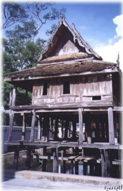
หอไตรของวัดอัมพวัน (ก่อนบูรณะ)
