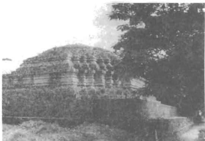
เจดีย์วัดวิหารทองหลังจากบูรณะแล้ว (ภาพจากมติชน ฉบับวันที่ 27 ธันวาคม 2545)
